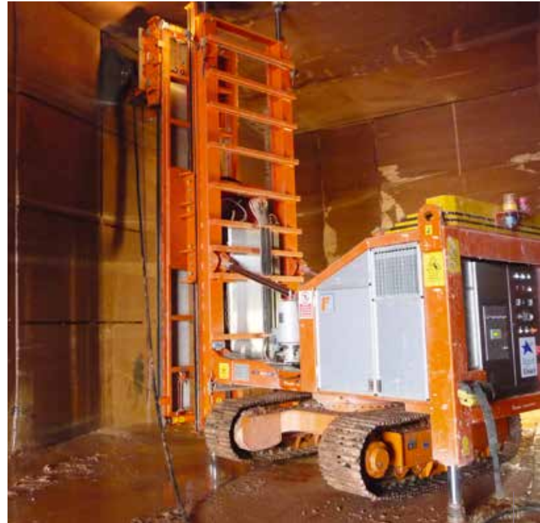
Le grès de Rothbach a la spécificité d'être extrait dans des galeries souterraines, au moyen de haveuses. Le tout sans produits explosifs, pour éviter de créer des microfissures et affaiblir mécaniquement la pierre.
