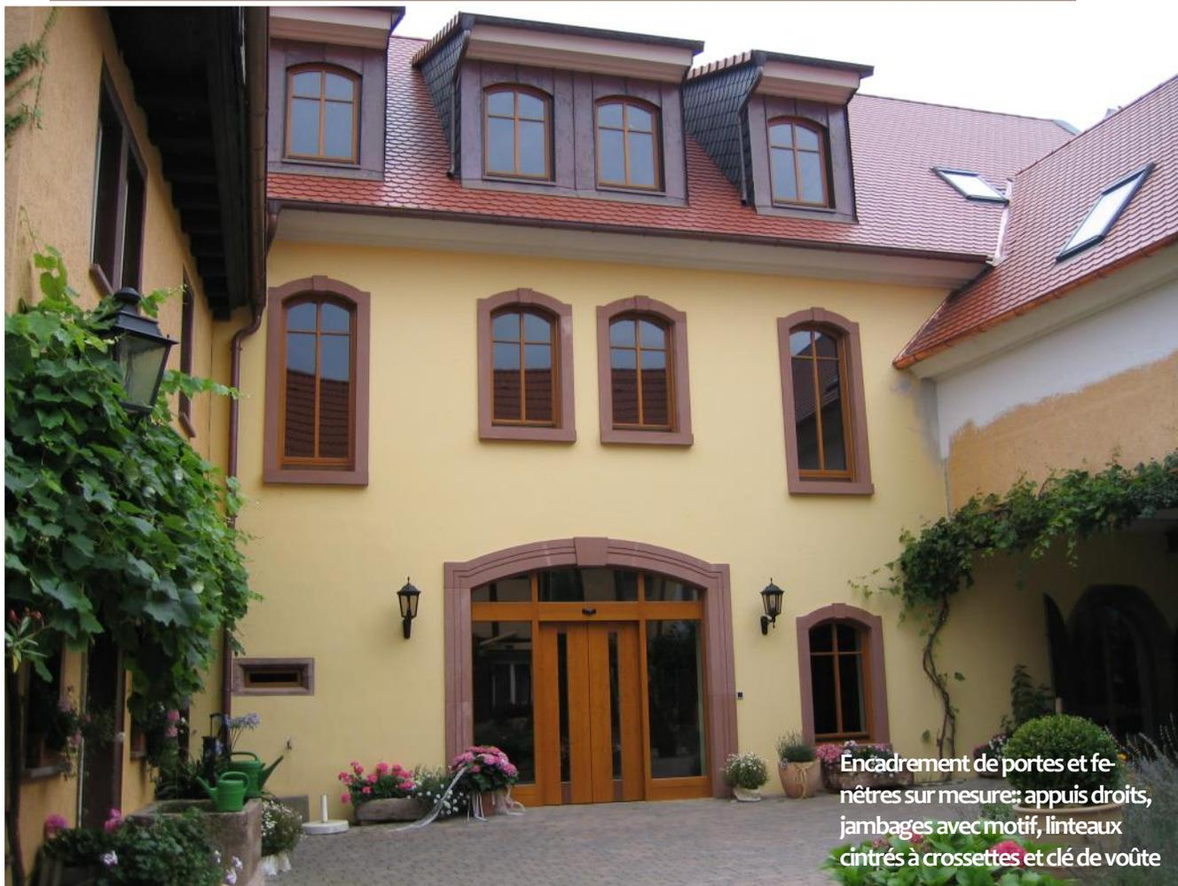
Encadrement de portes et fenêtres sur mesure; appuis droits, jambages avec motif, linteaux cintrés à crossettes et clé de voûte
